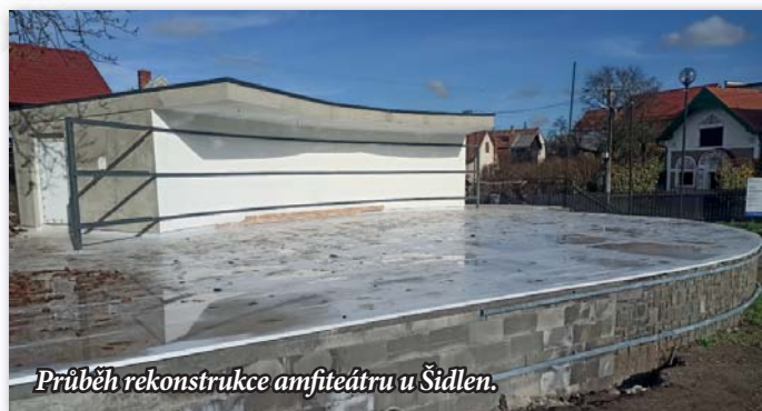
Průběh rekonstrukce amfiteátru u Šidlen.
