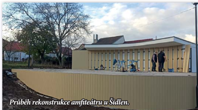
Průběh rekonstrukce amfiteátru u Šidlen.
