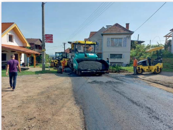
Oprava povrchu cesty u Šidlen
