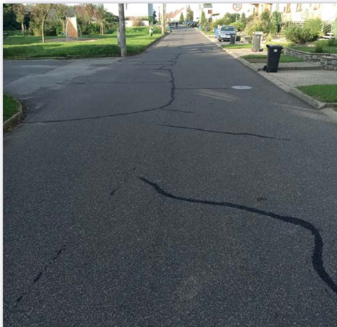
Asfaltem opravené díry na ulici Záluží
