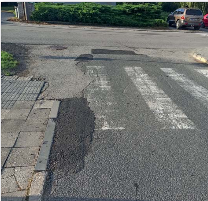
Asfaltem opravené díry na ulici Školní
