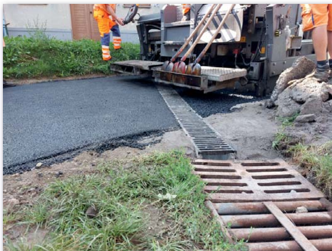
Oprava povrchu cesty u Šidlen
