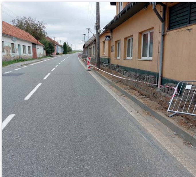
Přeložka elektrického vedení ulice Ratíškovská.
