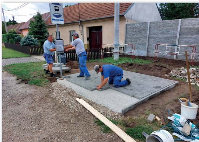
Pokládka dlažby pro zastávku U Statku.
