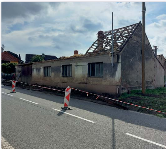
Demolice domu č.p. 225.
